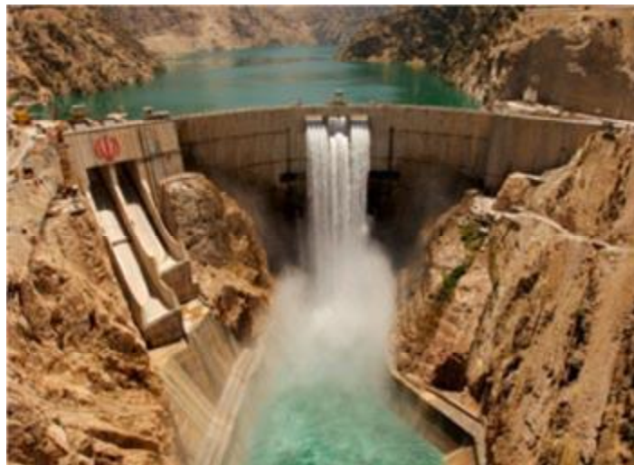
شکل (1-3): حوضچه استغراق سد کارون 3
