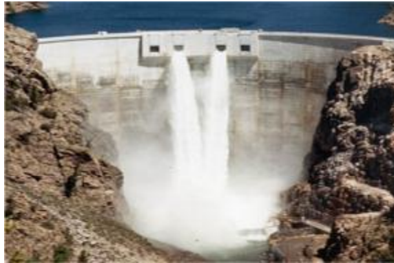
شکل (1-1): سد Morrow Point
