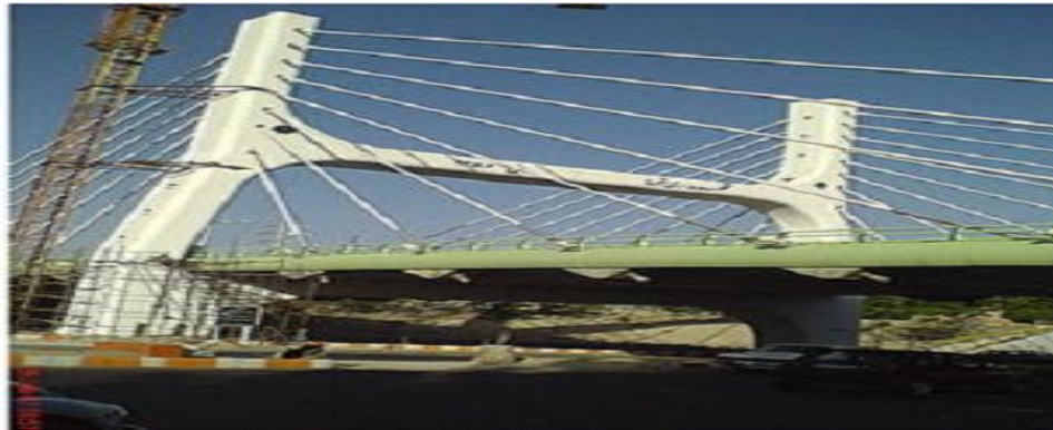
شکل ۶-۱: پل کابلی تبریز
