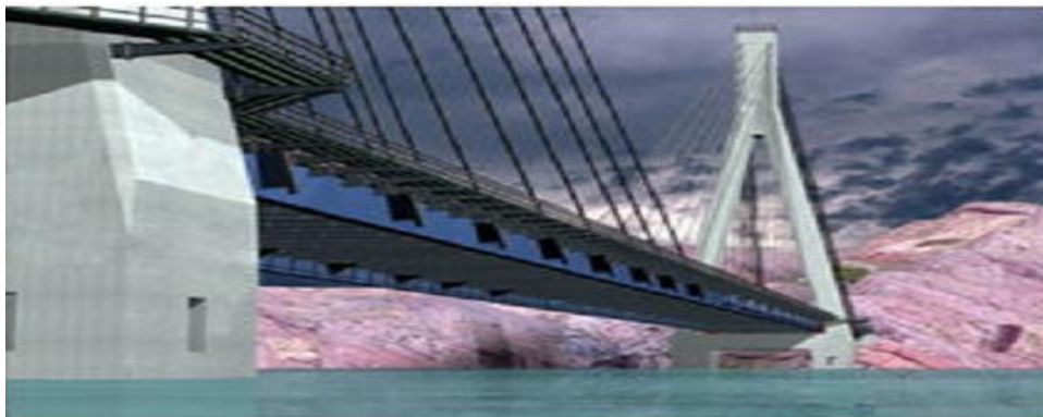
شکل ۷-۱: پل کابلی لالی
