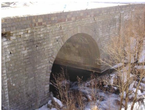
شکل ۱-۳: نمونه از پلهای طاقی در مسیر جاده کرج - چالوس
