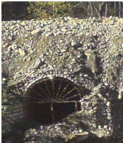
شکل ۱-۲: نمونه از پلهای طاقی سنگی اجرا شده در مسیر آزادراه تهران-شمال
