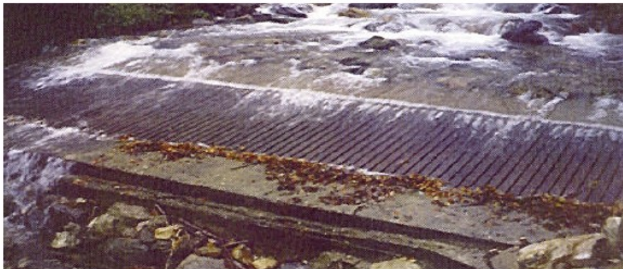
شکل (۱-۱) نمای کلی از یک کف مشبک [۳]
