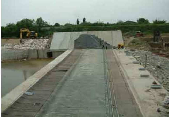
شکل ۲-۱۰: مراحل ساخت سد لاستیکی آرمیج کلا در نزدیکی بابلسر
