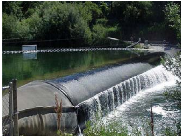
شکل ۲-۱: نمونه ای از سد لاستیکی جهت افزایش آبخور کشتی ها
