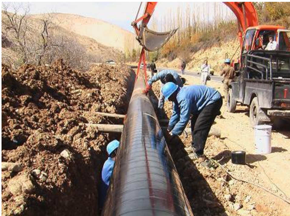
شکل ۱-۵ دفن لوله های حامل سیال
