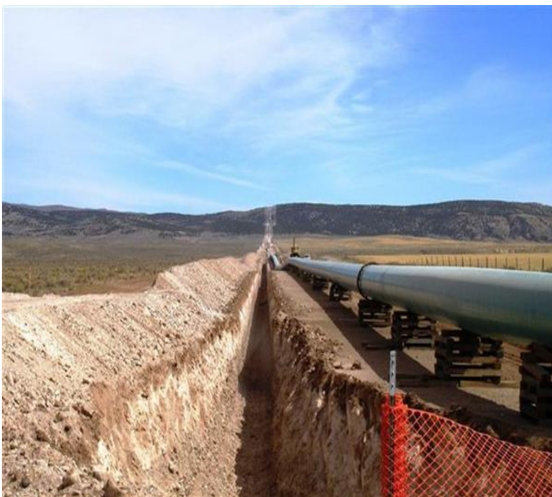
شکل ۴-۱ لوله های آماده برای دفن
