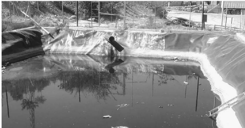
شکل (۱-۱) سد خاکی جهت ذخیره شیرابه‌ها در محل دفن زباله‌ها [۱]
