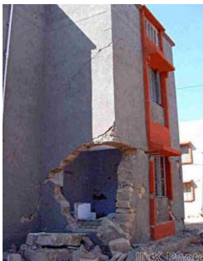
شکل ۲-۳ : خسارات ناشی از خرابی دیوارهای آجری.
