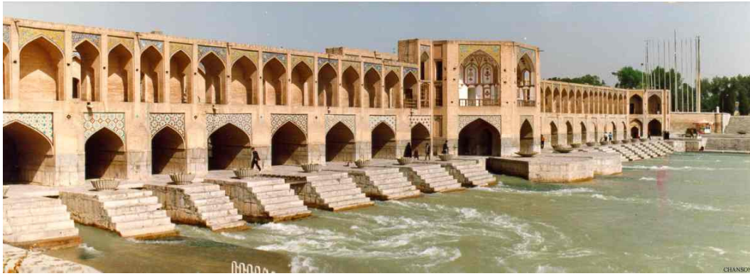
شکل ۱-۴. سرریز پلکانی پل خواجو (اصفهان-۱۶۵۰)
