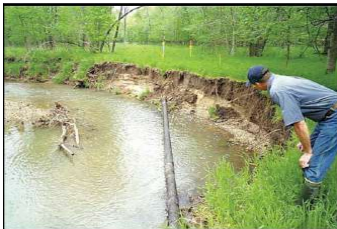
شکل ۱-۳- فرسایش ساحل و بستر رودخانه در محل قوس یک رودخانه
