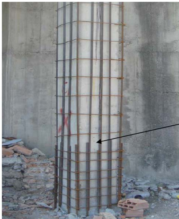
شکل ۱-۲ تقویت شدن به کمک کاشتن میلگرد
