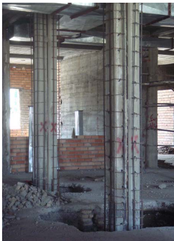
شکل ۵-۱ تقویت شدن به کمک کاشتن میلگرد
