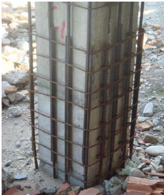
شکل ۱-۱ تقویت شدن به کمک کاشتن میلگرد
