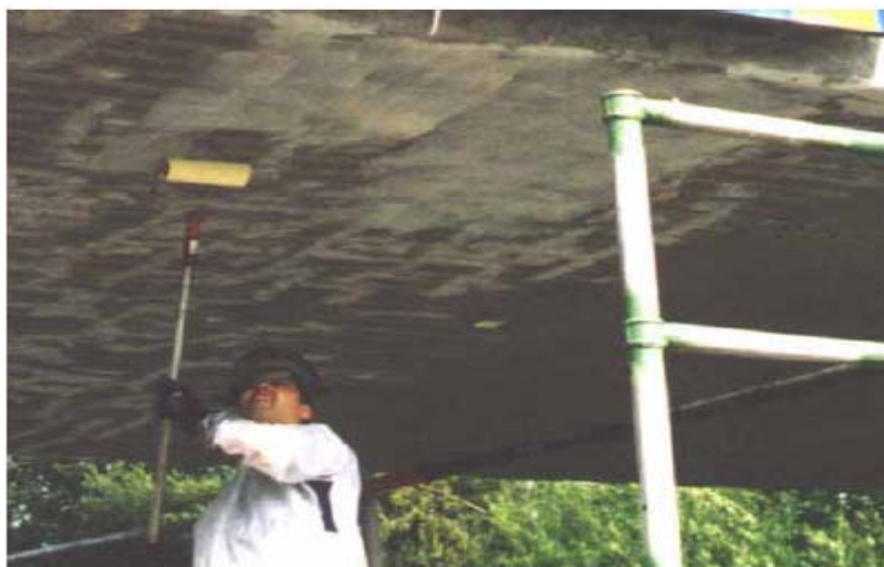
شکل ۱-۶ اتصال ورق FRP [۵]
