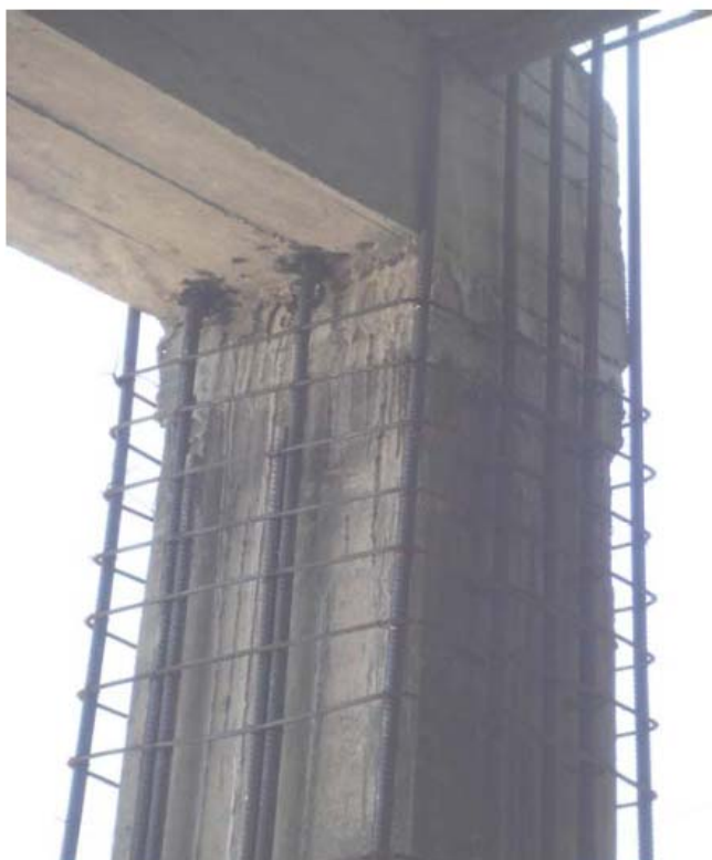
شکل ۱-۳ تقویت شدن به کمک کاشتن میلگرد
