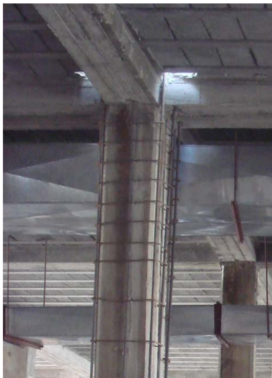
شکل ۴-۱ تقویت شدن به کمک کاشتن میلگرد
