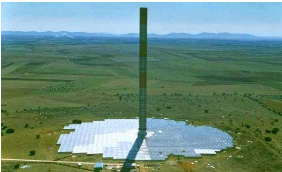
شکل ۱-۲: نیروگاه دودکش خورشیدی آزمایشی ساخته شده در مانتراس اسپانیا
