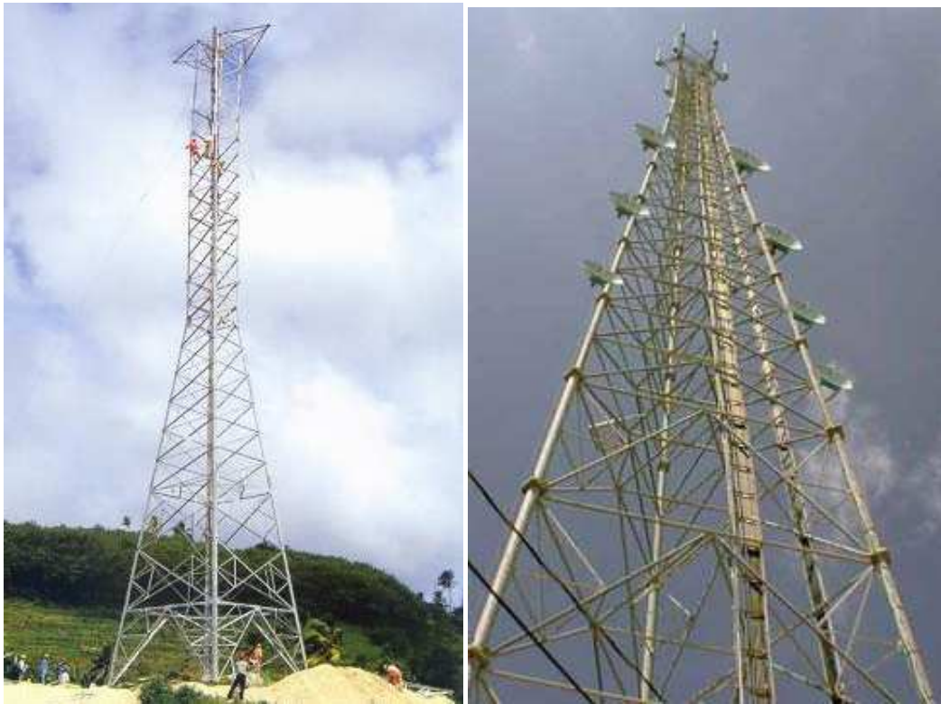
شکل ۴-۱ استفاده از خرپا در برج های مخابراتی (۴)
