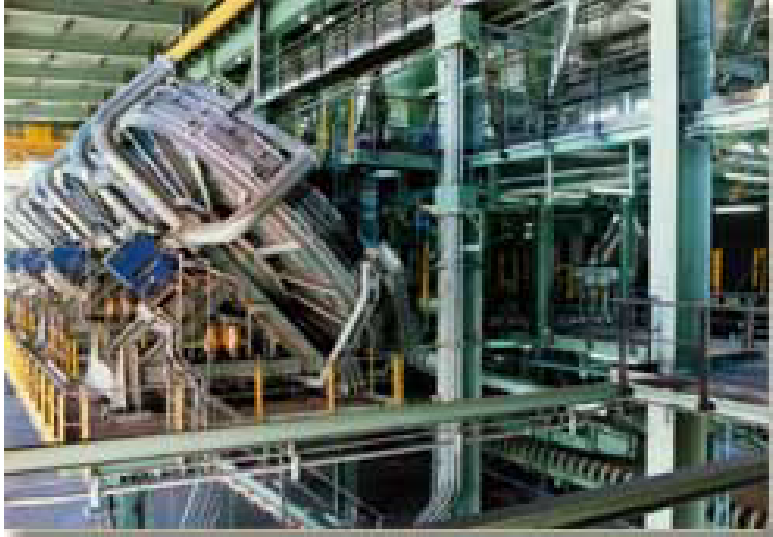
شکل ۱-۱: قسمتی از واحد گندله سازی در شرکت فولاد مبارکه اصفهان
