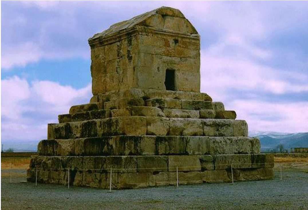
شکل (۲-۱): مقبره کوروش شاه هخامنشی قدیمی ترین سازه مجهز به سیستم کنترل جداساز فونداسیون [۱]
