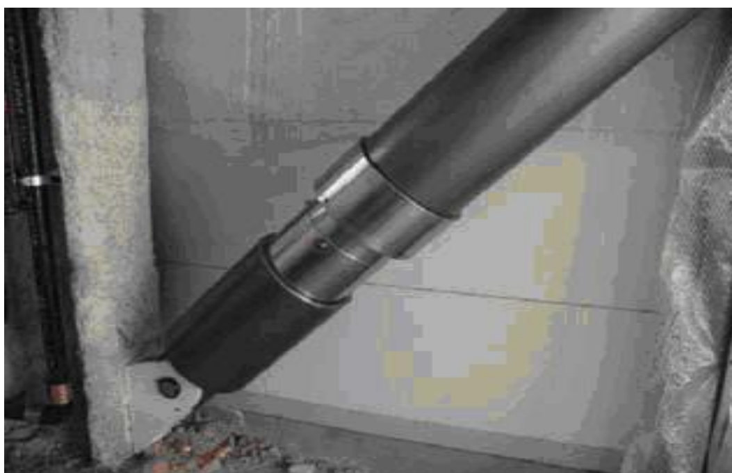
شکل (۲-۵): نحوه نصب میراگر ویسکوز مایع [۱]
