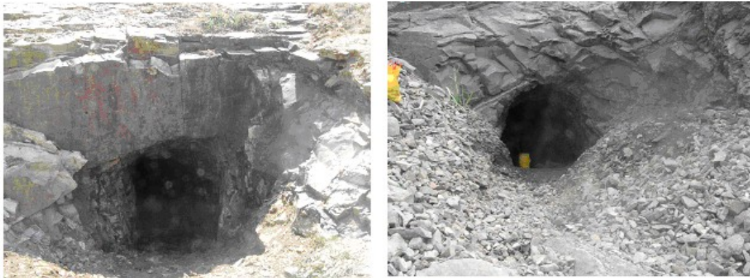
شکل ۱-۵- دهانه ورودی دو تونل در محدوده مورد مطالعه که به منظور پی جویی ممولیدن در لایه های توفی حفر شده است.
