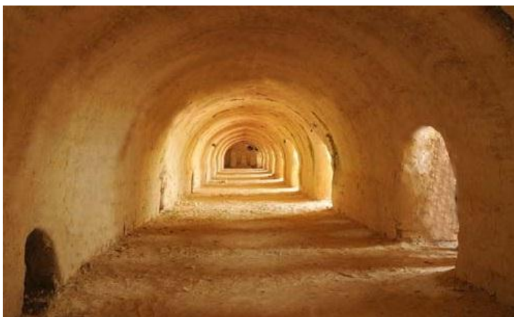
شکل ۲-۲- نمای داخلی یک کوره هافمن
