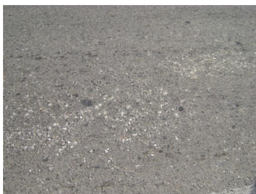
شکل ۱-۶- صیقلی شدن دانه‌ها
