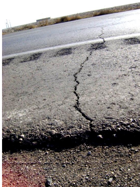
شکل ۱-۴- ترک انعکاسی درز
