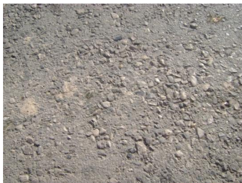
شکل ۱-۷- هوازدگی و دانه‌دانه شدن
