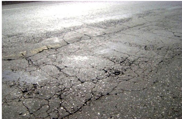
شکل ۱-۳- ترک بلوکی
