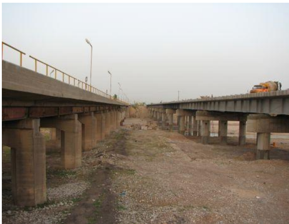
شکل ۱-۱: نمایی از پل بالارود جنوبی (ماشین رو) قبا از آب شستگی سال ۱۳۷۳
