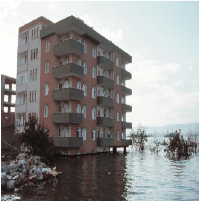
شکل (۳) : ساختمانی که در اثر زلزله ۱۷ آگوست ۱۹۹۹ Kocaeli ترکیه خسارت اندکی دیده و طبقه اول آن در زیر آب فرو رفته . [2]
