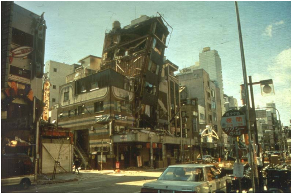
شکل ( ۱ ) : سازه خسارت دیده در زلزله کوبه و ناپایدار شده [1]
