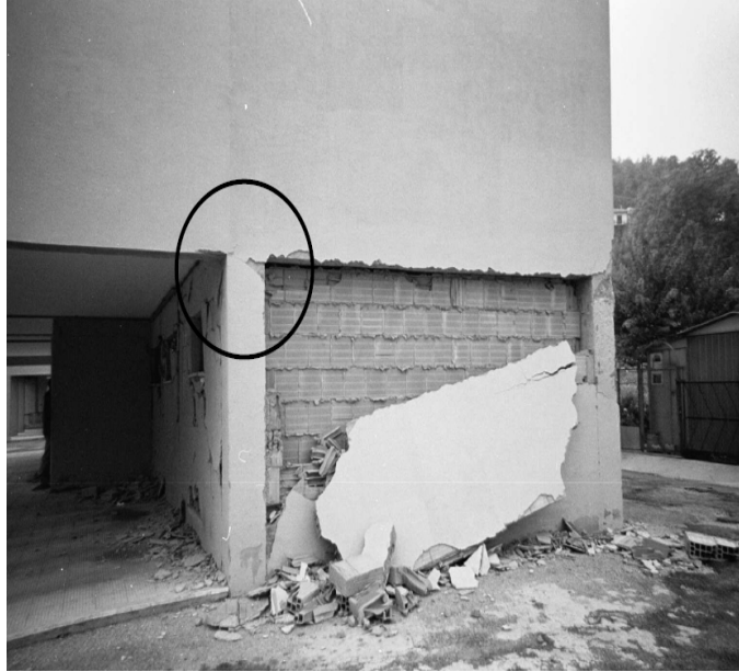
شکل (۶) : اتصال ستون بتنی بعد از زلزله ۳۱ اکتبر ۲۰۰۲ در Molise ایتالیا که سالم مانده است. [4]
