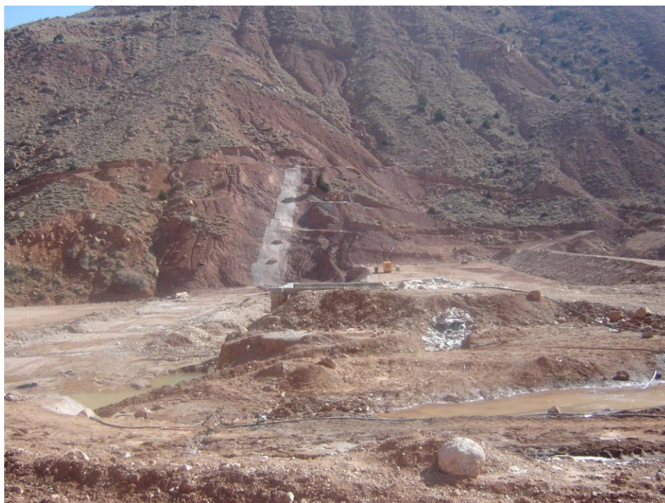
شکل (۱-۱) . نمایی از ساختگاه سد مجن در حال احداث ( نگاه به سمت جنوب).
