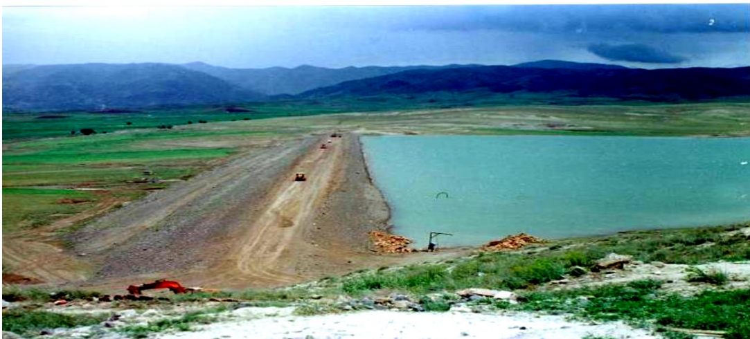
شکل ۳-۱ نمایی از سد قیصرق بعد از اجرای طرح اصلاح
