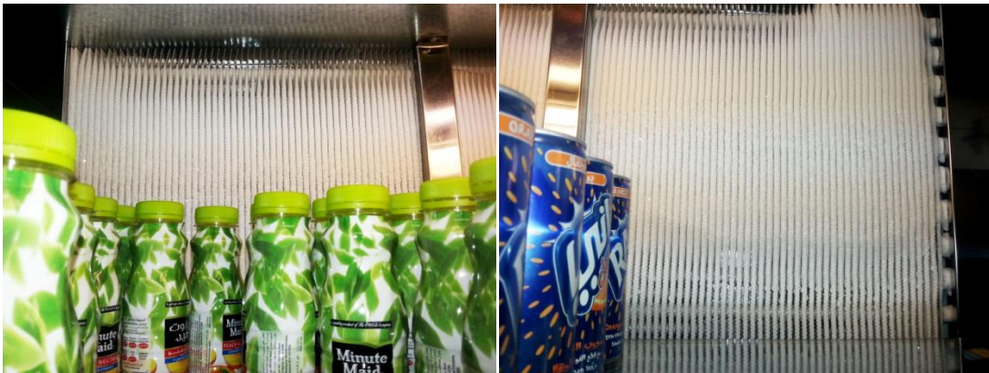
شکل ۱-۱: تشکیل برفک روی مبدل لوله و پره در جابجایی طیعی
