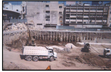
شکل ۱-۲: سپر شمع‌های مجاور درجا بعنوان سیستم مهاری (Jardaneh, ۲۰۰۶)
