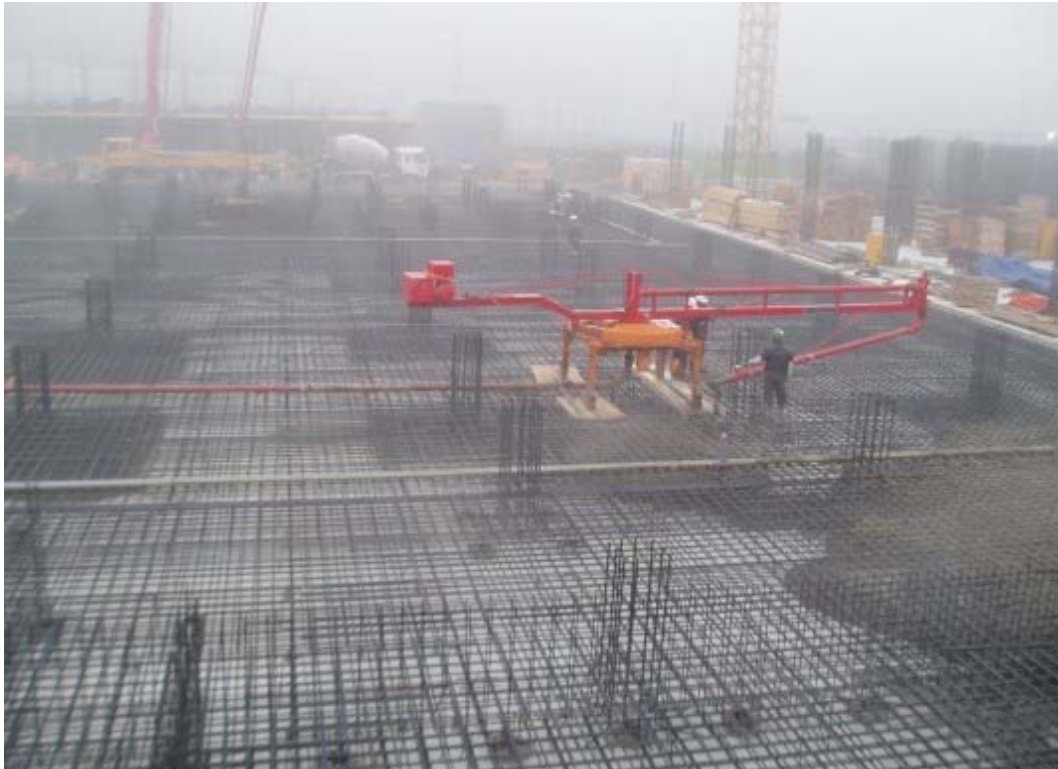
شکل (۱-۱) بتن ریزی در حجم وسیع- بتن بیشترین حجم مصالح ساختمانی می باشد
