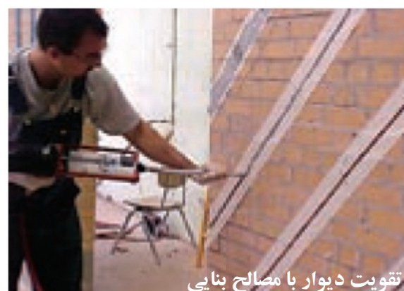
شکل 1-6- موارد تقویت با FRP
