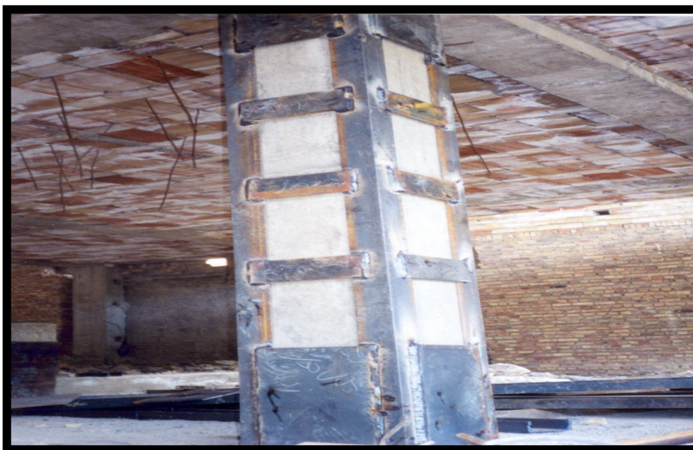
شکل ۳-۱ استفاده از جاکت های فولادی در مقاوم سازی موضعی ستون های بتنی
