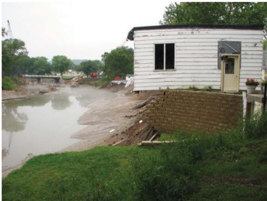
شکل (۱-۱): نمونه‌ای از فرسایش جداره رودخانه به هنگام سیلاب
