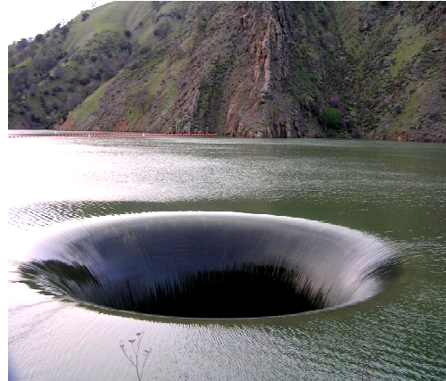
تصویر ۱-۴: جریان آزاد در سرریز نیلوفری سد مونیتسلو [۴]
