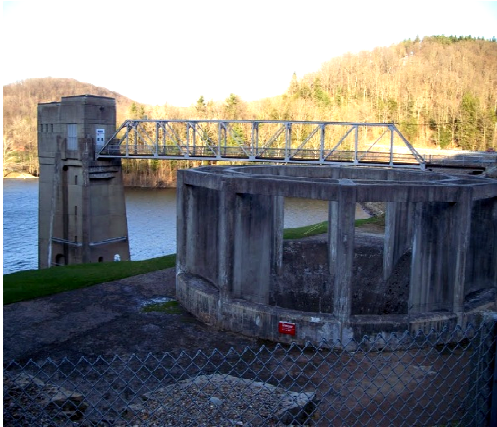
تصویر ۱-۵: تاسیسات ضد گرداب در سرریز سد هیل ۲
