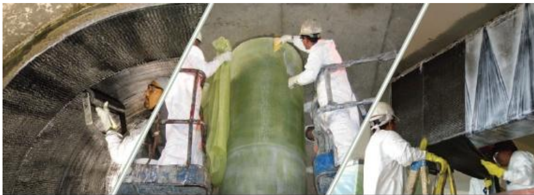
شکل 1-2 استفاده از ورقه‌های FRP در مقاوم سازی سازه‌ها [3]
