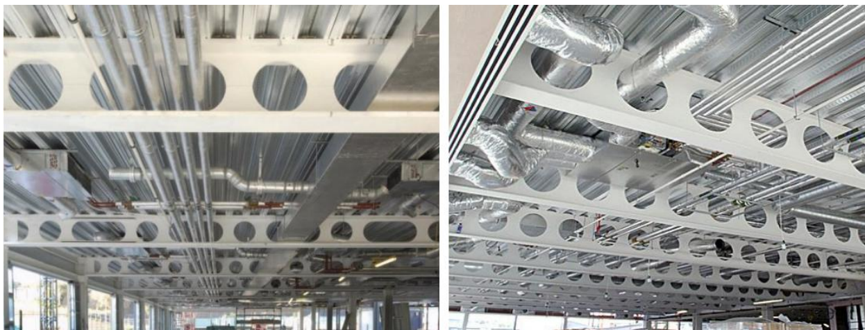
شکل ۱-۲: سوراخ‌های جان در تیرهای لانه‌زنبوری محل عبور تأسیسات
