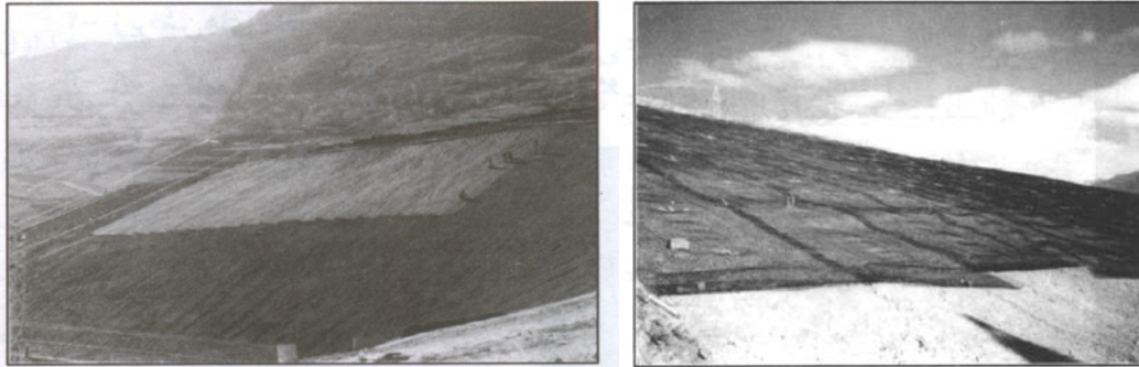
شکل 2-5- استفاده از ژئوگرید برای تثبیت شیب [1]
