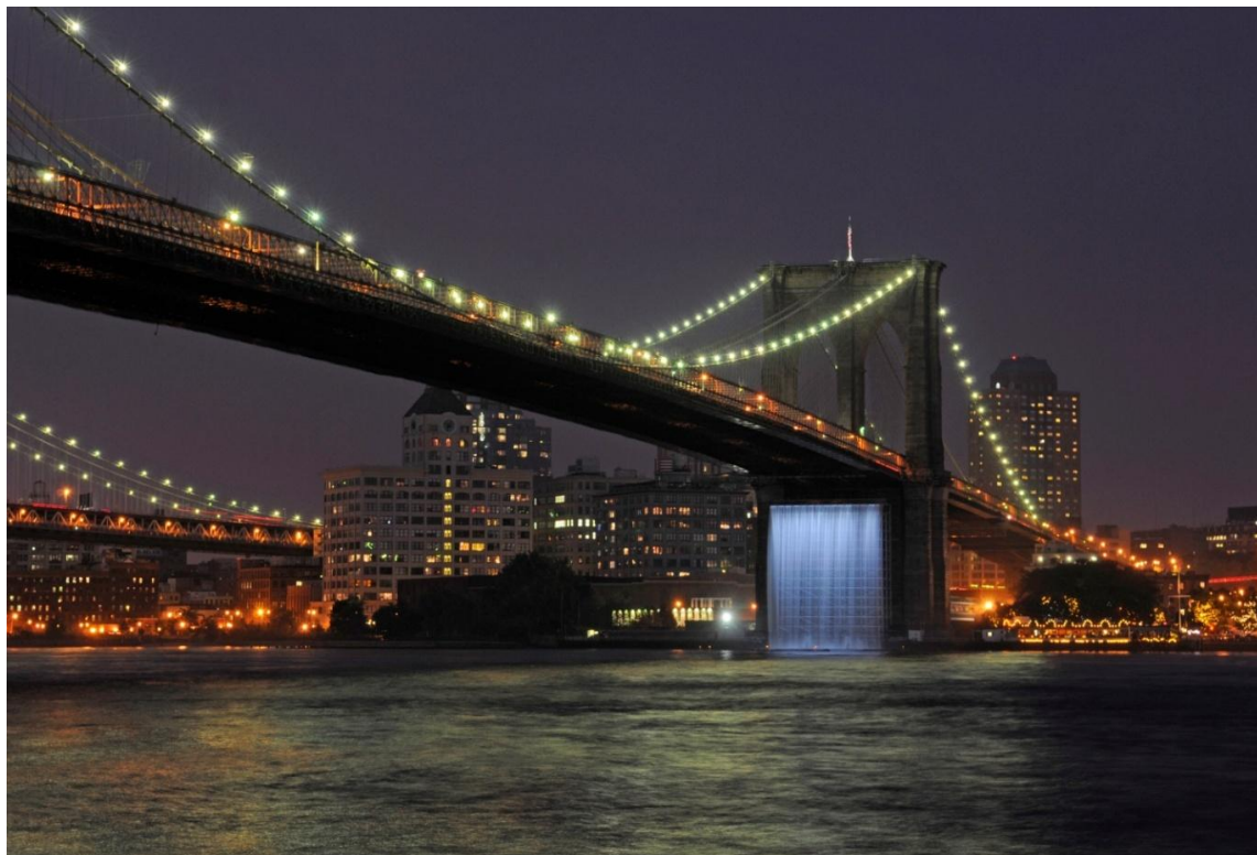
تصویر ۱-۱ - پل بروکلین - نیویورک - طراحی آبشار در پایه پل
