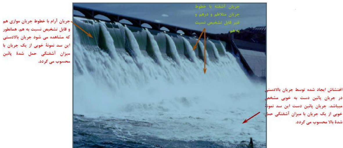
شکل ۱-۱ تبدیل جریان لایه‌ای به جریان آشفته و افزایش اغتشاش جریان در پائین دست آن
