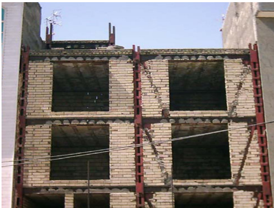
شکل (۱-۲): اشتباه مرسوم در استفاده از تیرهای لانه زنبوری در تیر پیوند سیستم واگرا [۱۲]
