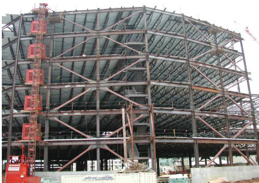
شکل (۱-۲): نمونه‌ای قابهای مهاربندی همگرای ویژه
