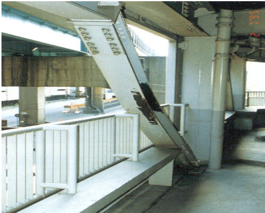
شکل (۳-۱): کمانش داخل صفحه مهاربند همگرا [۷]
