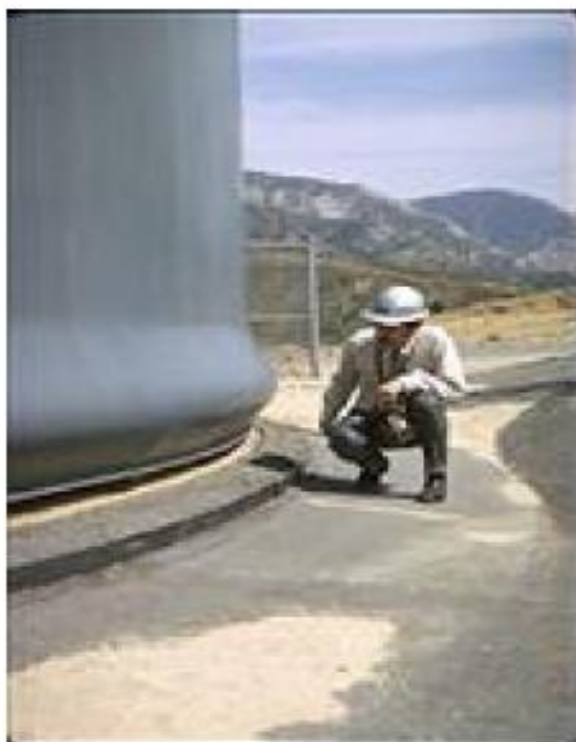
شکل 4-1 کمانش پافیلی پوسته مخزن
