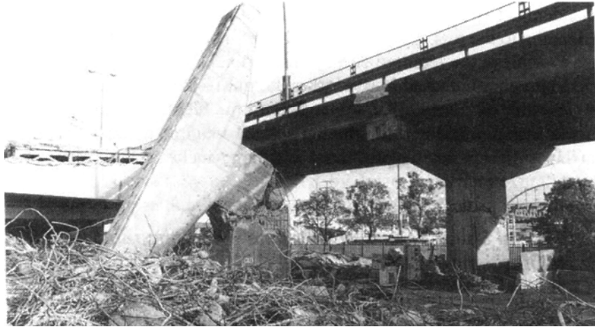
شکل (۵-۱): خرابی برشی - خمشی در وسط ارتفاع ستون و در محل قطع میلگردهای طولی [۵]
