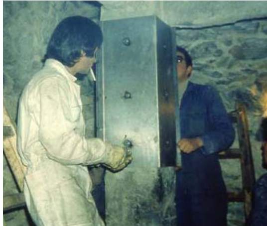
شکل (۸-۱): ورق پوش فولادی ستون بتن مسلح [۸]
