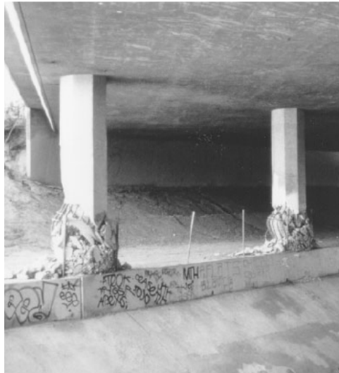
شکل (۱-۱): شکست خمشی در ستون [۵]
