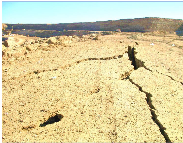
شکل ۱-۲ پدیده عقب زدگی در معدن سرب و روی انگوران
