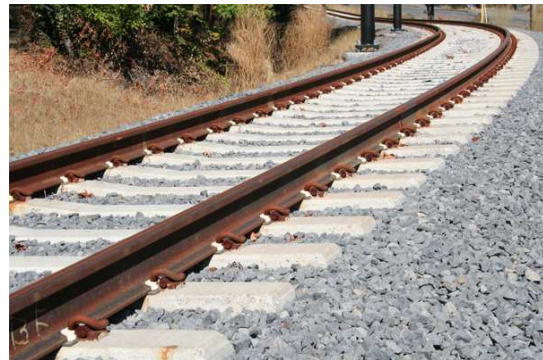
شکل ۱-۱ نمونه‌ای از خطوط بالاستی
