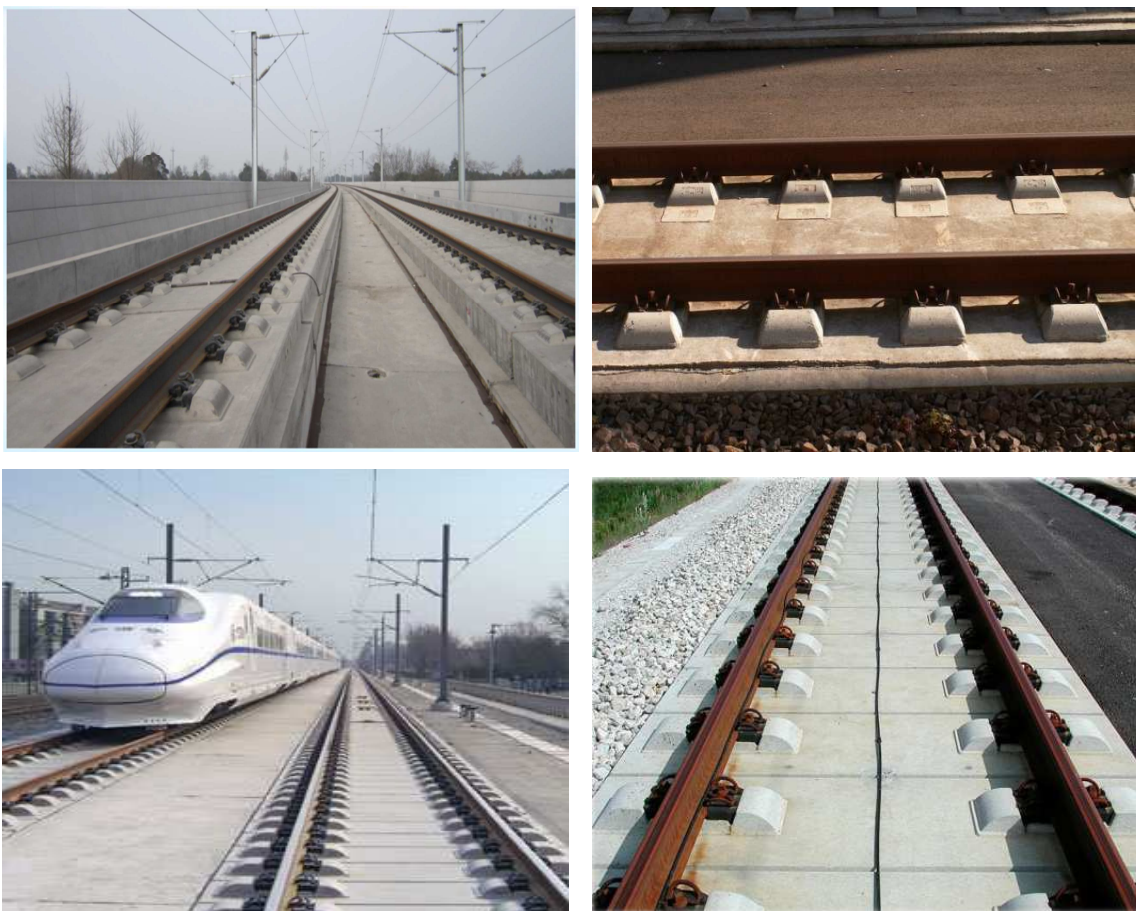
شکل ۱-۵ نمونه‌های خطوط بتنی اجرا شده
