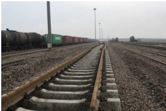
شکل ۱-۱ نمونه‌ای از خطوط بالاستی
