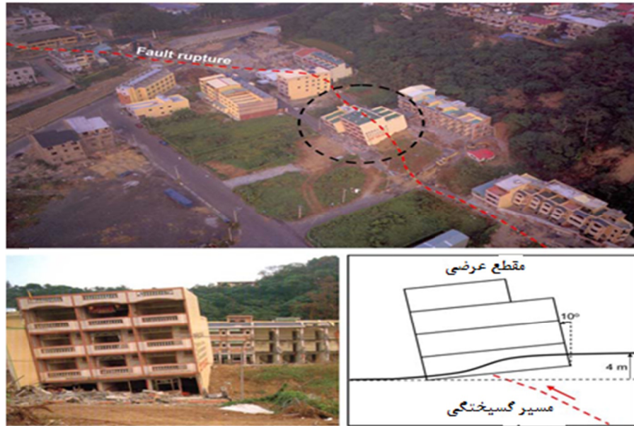
شکل (۲-۴): گسل چلونگیو، چی - چی، زلزله ۱۹۹۹ تایوان، ساختمان چهار طبقه روی فنداسیون پیوسته
