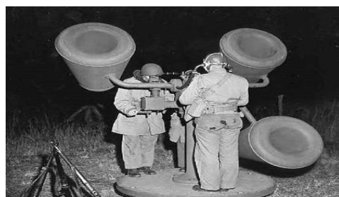
شکل ۶: رادار گیرنده صوتی آمریکایی، تعیین کننده جهت حرکت پرنده (۱۹۴۳) [۳۴]
