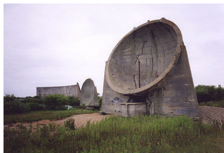
شکل ۲: تصویری از یک سیستم رادار صوتی مورد استفاده انگلستان (۱۹۲۸) [۳۴]
