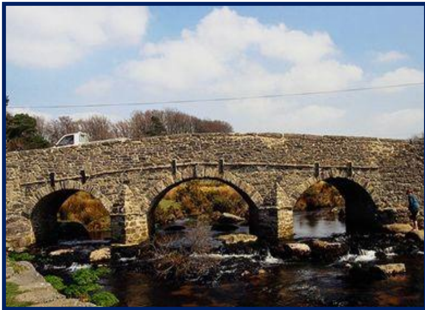
(شکل ۱-۱) نمونه‌ای از یک پل قدیمی
