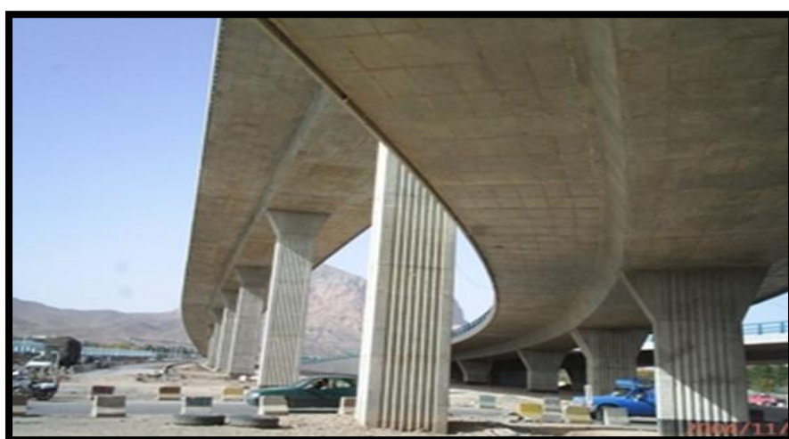
(شکل ۱-۳) نمونه ای از یک پل بتنی
