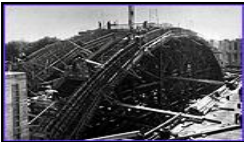
(شکل ۱۰-۱) اجرای درجا با قالب بندی کامل
