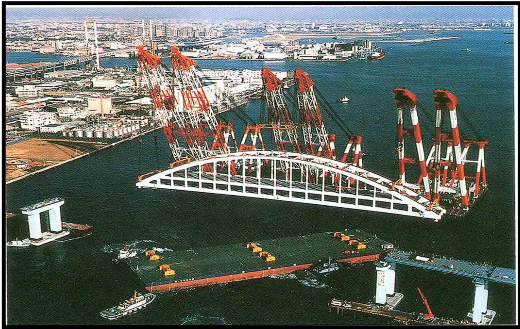
(شکل ۱-۱۲) حمل با بارج و نصب با جرثقیل
