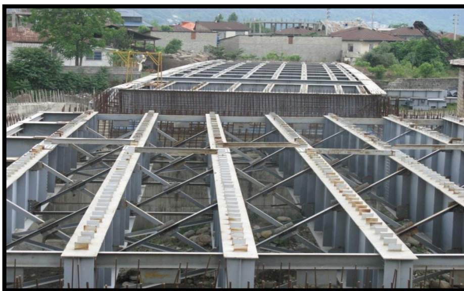
(شکل ۱-۴) پل با تیر و شاه‌تیر در رامسر
