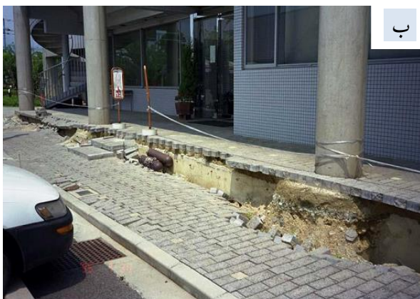
شکل (۲-۱۲): الف) نشست آپارتمان و تکیه دادن به ساختمان مجاور به علت روانگرا شدن خاک زیر پی در زلزله ترکیه ب) نشست پیاده‌رو در زلزله نیشینومیا [۱۰]
