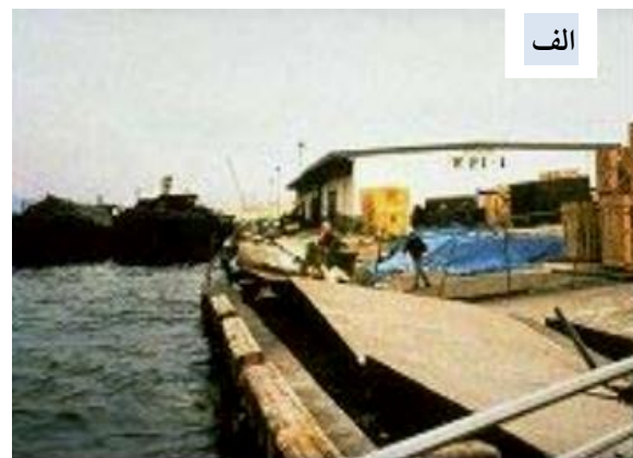
شکل (۲-۱۱): الف) خرابی دیوار حایل و حرکت جانبی آن بر اثر روانگرایی ب) جابه‌جایی اسکله در جزیره پورت بر اثر روانگرایی خاک [۱۰]
