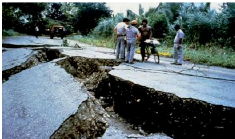
شکل (۷-۲): خرابی جاده بر اثر روانگرایی لایه‌های زیرین [۱۰]
