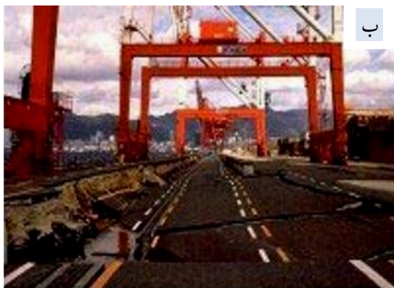
شکل (۲-۱۱): الف) خرابی دیوار حایل و حرکت جانبی آن بر اثر روانگرایی ب) جابه‌جایی اسکله در جزیره پورت بر اثر روانگرایی خاک [۱۰]
