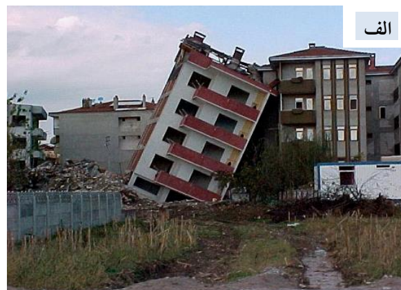
شکل (۲-۱۲): الف) نشست آپارتمان و تکیه دادن به ساختمان مجاور به علت روانگرا شدن خاک زیر پی در زلزله ترکیه ب) نشست پیاده‌رو در زلزله نیشینومیا [۱۰]
