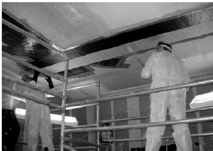
شکل ۱-۱- تقویت دال با استفاده از الیاف CFRP قبل از ایجاد بازشو، به منظور عبور کانال تهویه [۲]
