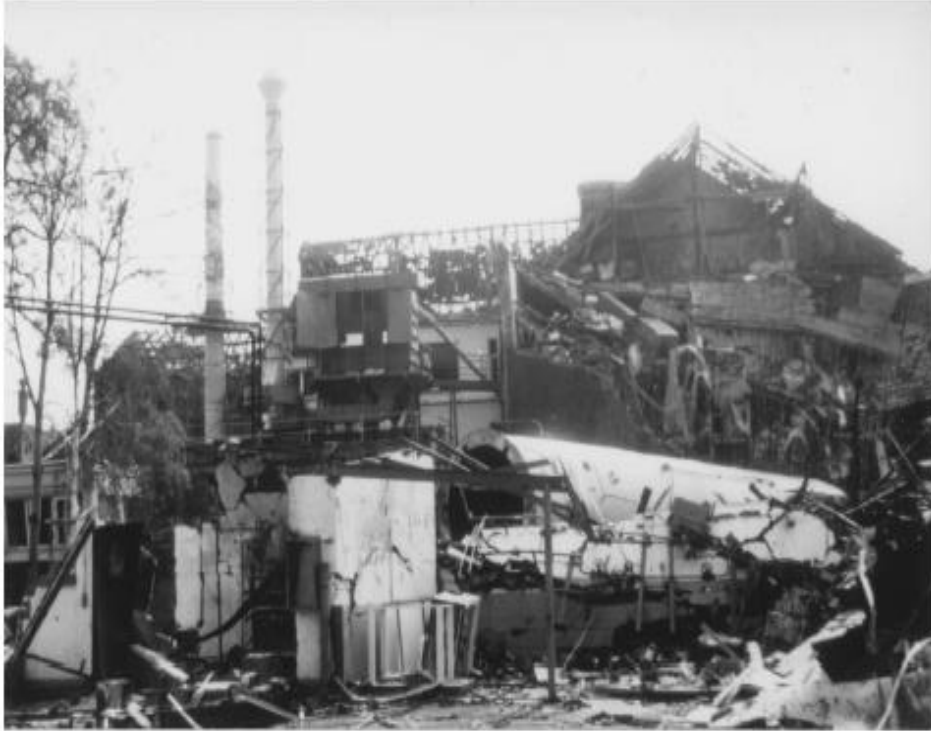
شکل 1-2: تخریب کارخانه پس از انفجار مخزن هیدروژن [7]
