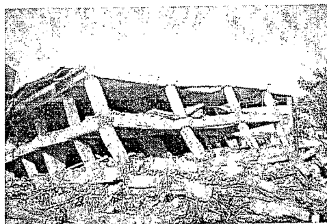
شکل ۱-۱ خرابی سازه‌های بتنی در زلزله ترکیه، سال ۱۹۹۹، [۲۳]
