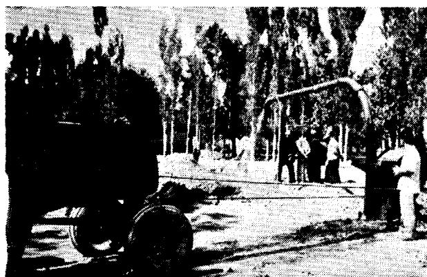
بدینوسیله دسته های علوفه رویهم فشرده میشوند در داخل ماشین چند تیغه برنده قرارداد که در طول محوری با سرعت میگردند و بتدریج که علوفه فشرده وارد محوطه میشود بقطعات تقریباً ۵ سانتیمتری بریده شده پیوین محوطه اینسته میریزد در این موقع هوا بوسیله یک پروانه قوی که با سرعت میچرخد از یکظرف داخل شده و بطرف دیگر که لوله بلندی وصل است رانده میشود .
