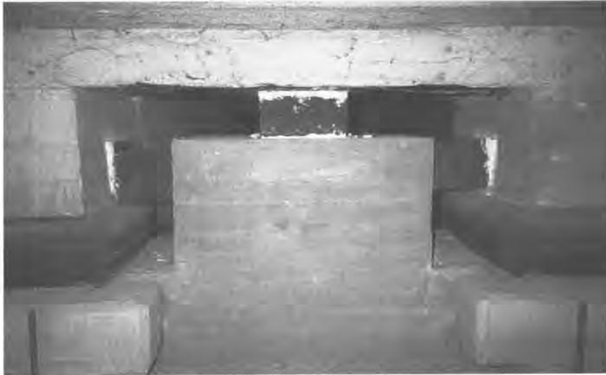
شکل ۲-۴- جداگر لرزه ای استفاده شده در مدرسه شهر skopje [۱]
