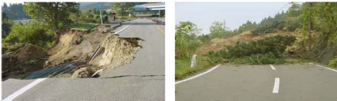
شکل ۱-۱: خرابی دیوار و جاده در اثر زلزله Mid-Nigata ژاپن به بزرگی ۶.۸ ریشتر در ۵ دسامبر ۲۰۰۴
