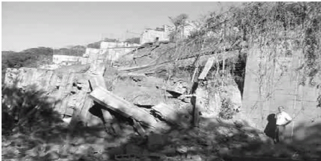
شکل ۱-۲: نمونه خرابی دیوار و جاده در اثر زلزله السالوادور در ژانویه ۲۰۰۱
