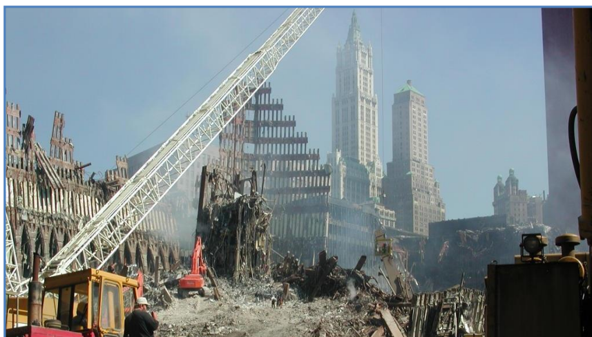
شکل ۱-۲- خرابی پیشرونده در برج‌های دوقلوی مرکز تجارت جهانی (WTC) شهر نیویورک سال ۲۰۰۱
